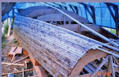
① まず最初に、ストリップブランキングで、木材(レッドシダー)で船体そのものを組み上げていく。レッドシダーは軽いので、芯材として適している
